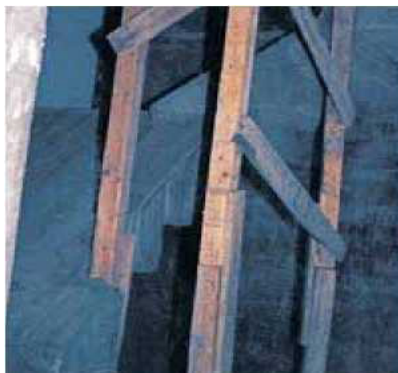
▲ Καλή προστασία στο φανάρι (κουβάς) κλιμακοστασίου
