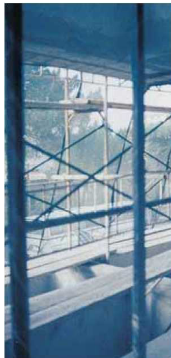
◀ Σκαλωσιά που απαιτεί και εσωτερική προστασία του δαπέδου εργασίας έναντι πτώσης (το δάπεδο εργασίας απέχει περισσότερο από 30cm από την όψη του κτιρίου) ►
