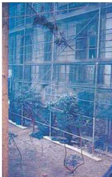
◀ Ορθή έδραση σκαλωσιάς σε έδαφος (το μαδέρι μπορεί να παραιοφθεί σε σκληρή επιφάνεια έδρασης).
