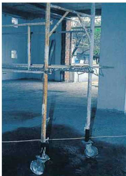
▲ Οι τροχοί στους πύργους πρέπει να έχουν φρένα σε καλή λειτουργία.
