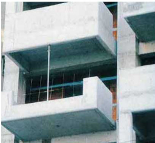
▲ Ασφαλής προστασία στα πέρατα των εξωστών με πατοκολώνες και οικοδομικό πλέγμα/ σανίδια.
