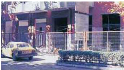
▲ Καλή περίφραξη εργοταξίου. Οργανωμένο εργοτάξιο.
