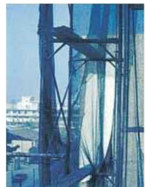
Ανασφαλή δάπεδα εργασίας (απατείται και δεύτερο μαδέρρι). ►
