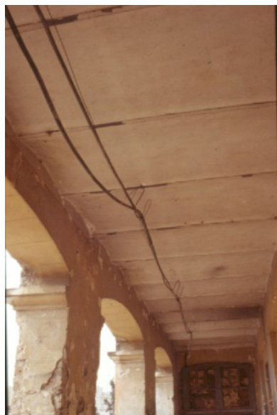
▲ Ασφαλής ανάρτηση καλωδίων.
