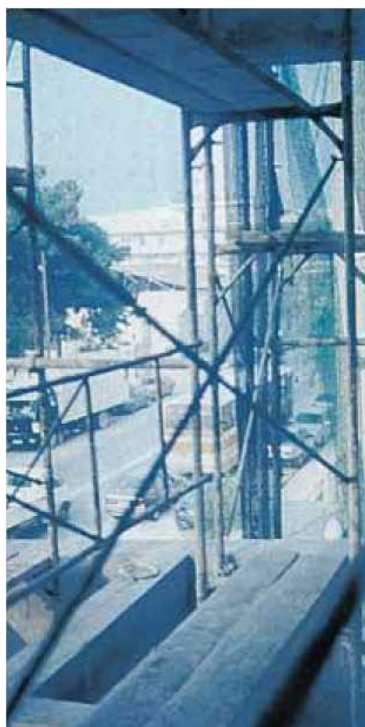
◀ Σκαλωσιά που απαιτεί και εσωτερική προστασία του δαπέδου εργασίας έναντι πτώσης (το δάπεδο εργασίας απέχει περισσότερο από 30cm από την όψη του κτιρίου) ►
