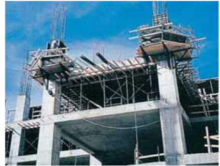
▲ Ασφαλείς σκαλωσιές εξωτερικών τοιχείων και στύλων.
