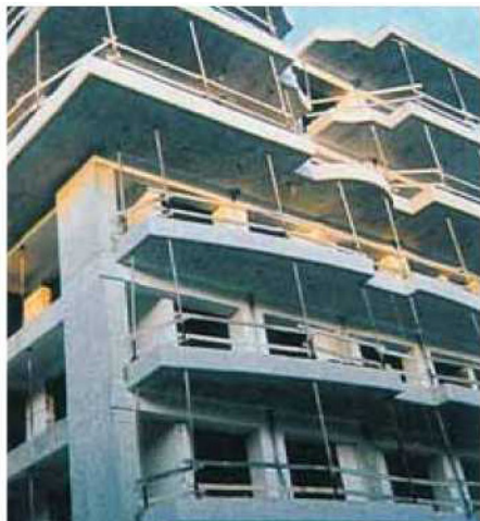
▲ Ασφαλής προστασία στα πέρατα των εξωστών με πατοκολώνες και οικοδομικό πλέγμα/ σανίδια.
