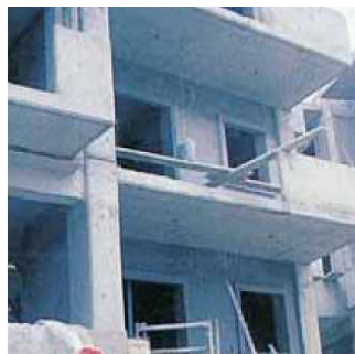
Σοβατά κινδύνοι με εξώστες χωρίς προστασία έναντι πτώσης και απαρδέκτα δάπεδα εργασίας. Άμεσος κίνδυνος πτώσης.
