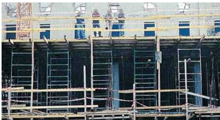
▲ Ασφαλής προστασία και σήμανση στα πέρατα ξυλότυπου.
