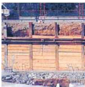
Αντιστήριξη θεμελίων κτιρίου. ▼
