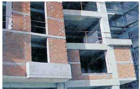
Προστασία περάτων πλακών (στα ανοίγματα αυτά θα τοποθετηθούν αργότερα υαλότουβλα) και εξωστών.
