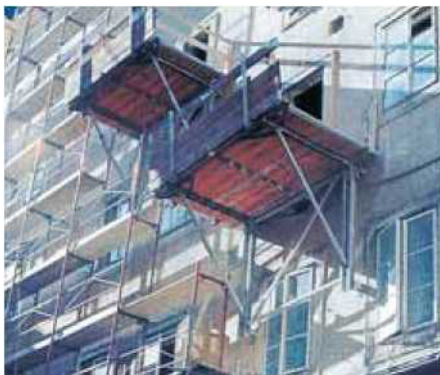
◀ Δάπεδα εργασίας. Πλήρες μαδέρωμα - προστασία έναντι πτώσης. Πλήρες μαδέρωμα - ελλιπής προστασία έναντι πτώσης.
