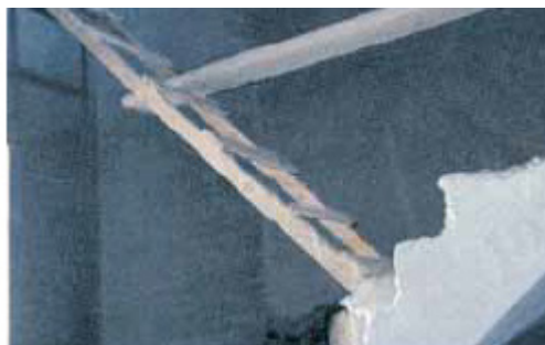
▲ Λανθασμένη και ανασφαλής χρήση φορητών κλιμάκων για έδραση διαπέδων εργασίας.
