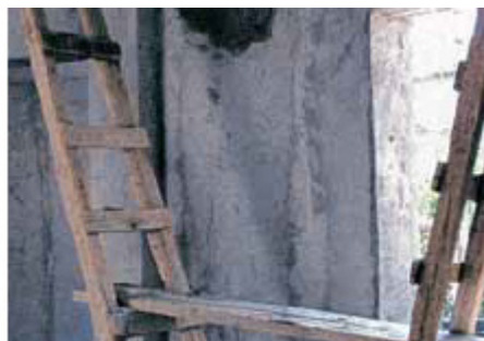
▲ Λανθασμένη και ανασφαλής χρήση φορητών κλιμάκων για έδραση διαπέδων εργασίας.
