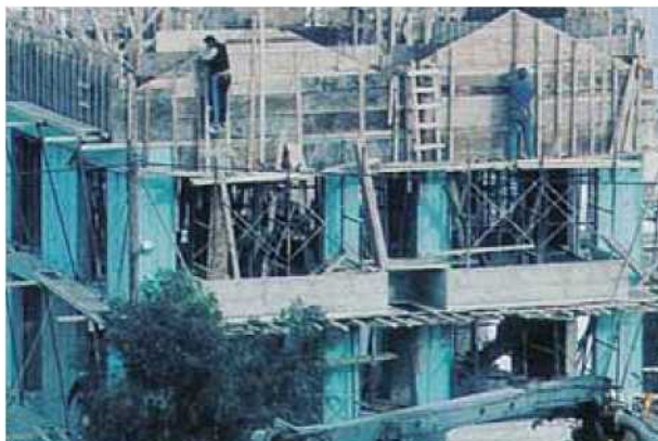
▲ Ανασφαλής χρήση φορητής σκάλας σε εξωτερικό δάπεδο εργασίας, απροστάτευτο έναντι πτώσης.
