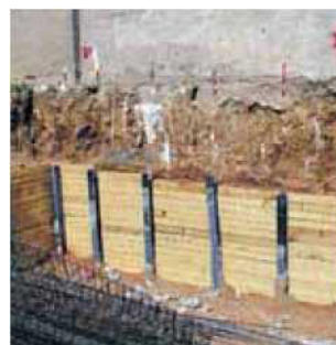
Αντιστήριξη θεμελίων κτιρίου. ▼
