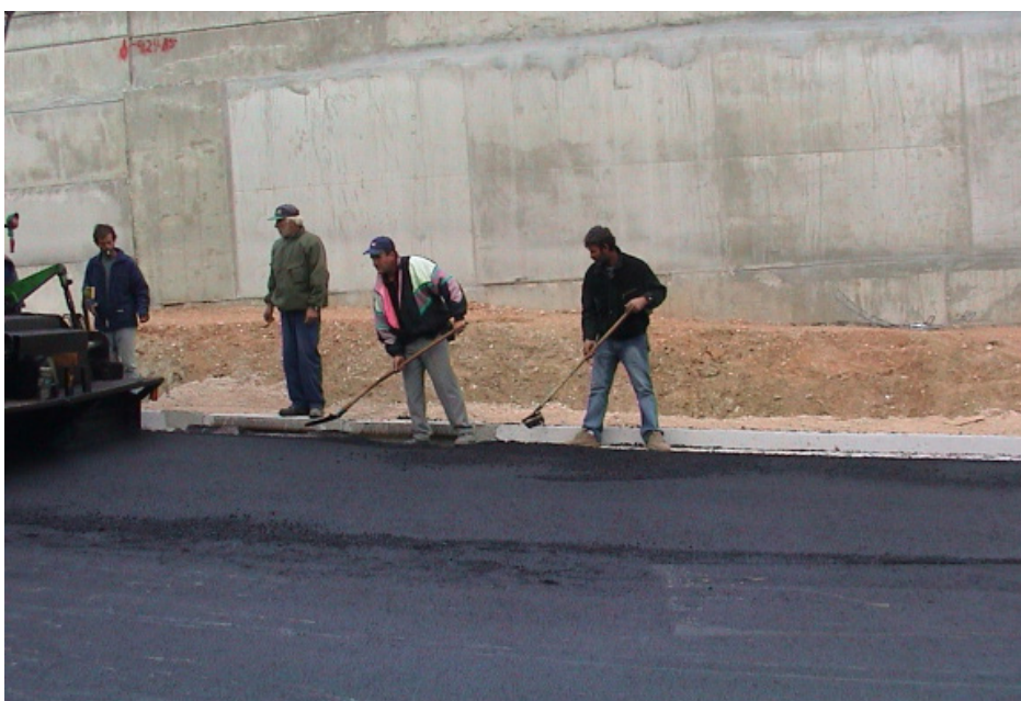
Εικόνα 3: Ασφαλτόστρωση, Εκτίμηση και πρόληψη επαγγελματικού κινδύνου σε έργα οδοποιίας, ΕΛΙΝΥΑΕ, 2008)
