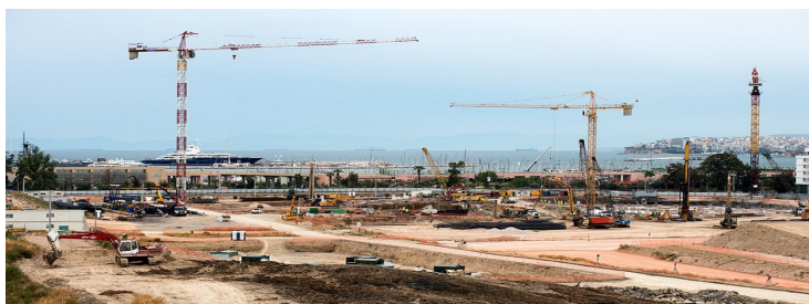
Φωτογραφία 3: Εργοτάξιο κατασκευαστικού έργου.
