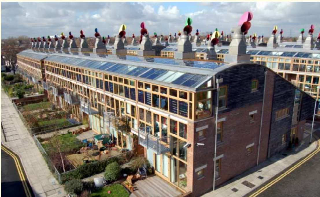
Ειδικές καμινάδες που χρησιμοποιούνται στη συνοικία BedZED στο Λονδίνο έτσι ώστε να εκμεταλλεύεται κανείς περισσότερο το φαινόμενο της καμινάδας και την αρχή του Bernoulli
