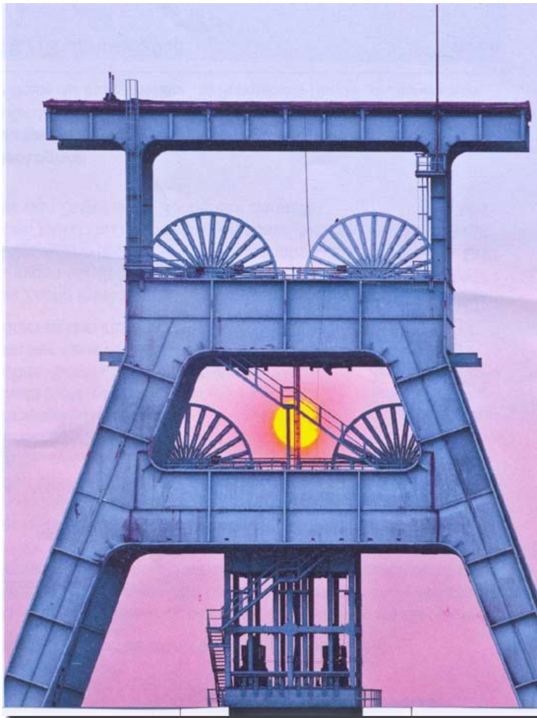
Μεταλλείο Ewald. Διπλό ικρίωμα μεταφοράς υλικών πάνω από τη σήραγγα 7 (Herten, Βόρεια Ρηνανία - Βεστφαλία).
