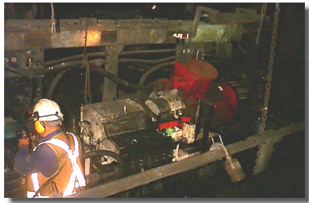
Εγκατάσταση αντλιοστασίου Υ.Τ.Ε (Inoxihp Australia).
