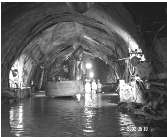
Πλημμύρα από είσοδο νερού στο μέτωπο: συνθήκη συνεχούς ροής στη διάρκεια της όρυξης της σήραγγας με TBM σε pilot tunnel με ταυτόχρονη συνεχιζόμενη αυξανόμενη αστάθεια της εκσκαφής λόγω της ταυτόχρονης διαρροής και μικροτεμαχίων πετρώματος. Φαίνονται κάποιες προσπάθειες ελάττωσης με σακιά άμμου.
