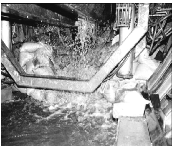
Πλημμύρα από είσοδο νερού στο μέτωπο: συνθήκη συνεχούς ροής στη διάρκεια της όρυξης της σήραγγας με TBM σε pilot tunnel με ταυτόχρονη συνεχιζόμενη αυξανόμενη αστάθεια της εκσκαφής λόγω της ταυτόχρονης διαρροής και μικροτεμαχίων πετρώματος. Φαίνονται κάποιες προσπάθειες ελάττωσης με σακιά άμμου.
