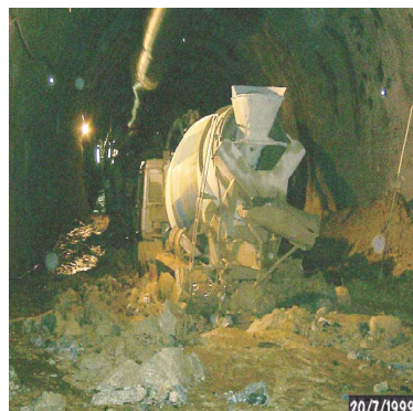
Μεγάλης κλίμακας εισροή υδάτων σε σιδηροδρομική σήραγγα (Blisadona, Αυστρία, 1999. Geotechnical Risking Rock Mass Characterization A-Concept. Irmina Poschl, Johannes Kleberger, April 2004)
