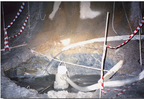
Αντλία μικρής δυναμικότητας εγκατεστημένη χωρίς σοβαρά μέτρα ασφάλειας: έλλειψη περίφραξης ή καλύμματος ασφαλούς με θυρίδα επιθεώρησης.
