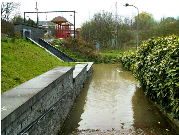
Πλημμυρισμένη σήραγγα από εξωτερικά, βρόχινα νερά, στο Frameries στο Βέλγιο (Minouchette Photos, 21/03/2008).
