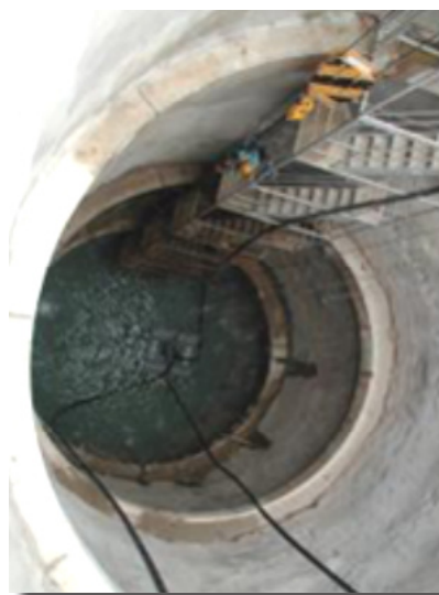
Φρέαρ προσπέλασης σε Υ.Τ.Ε με χρήση του πυθμένα του για υδατοσυλλογή, απ' όπου τα νερά αντλούνται στην επιφάνεια.
