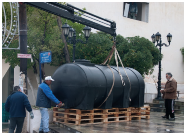
Τοποθέτηση δεξαμενής πόσιμου νερού στα Οινόφυτα.
