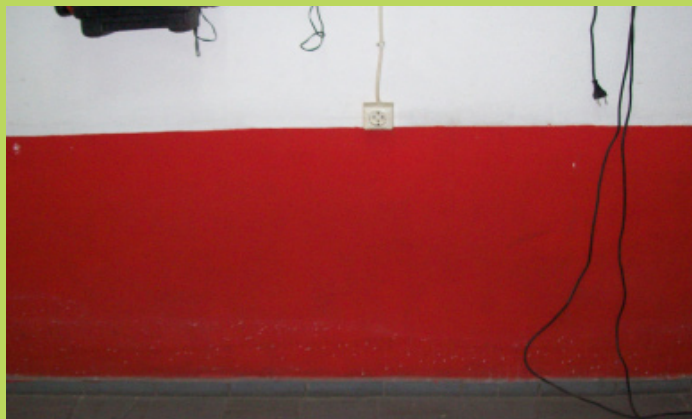
Εικόνα 7: Πρίζα μη στεγανού τύπου σε ακατάλληλο ύψος
