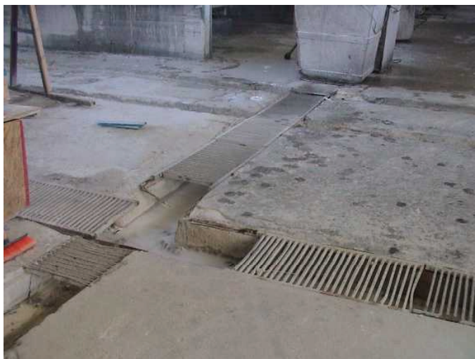
Εικόνα 2: Δάπεδο με ακατάλληλα καλύμματα καναλιών.
