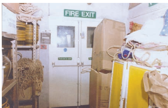
Εικόνα 7: Η ύπαρξη υλικών κοντά στην έξοδο κινδύνου εμποδίζει την ασφαλή διέλευση σε περίπτωση εκκένωσης.
