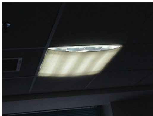
Εικόνα 9. Φωτιστικό μέσα στο οπτικό πεδίο εργαζόμενου, καλυμμένο από τον ίδιο για την αποφυγή θάμβωσης
