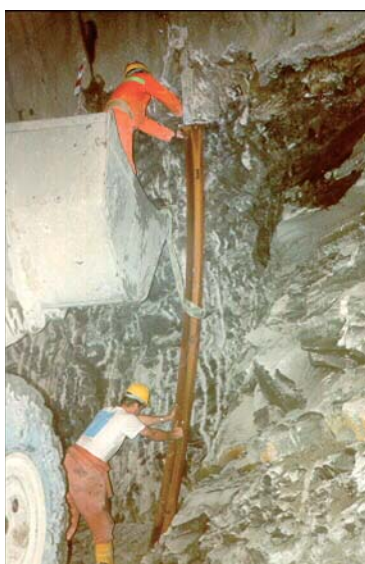
Φωτο 32: Εργαζόμενοι σε εργασία τοποθέτησης μεταλλικού πλαισίου σε σήραγγα, πάνω σε εκσκαφέα
