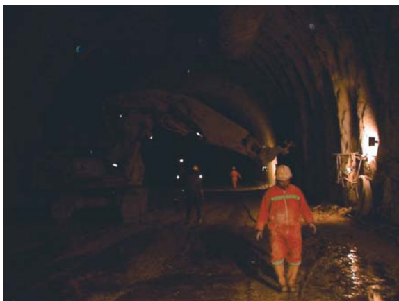
Φωτο 47: Προβολέας δίπλα σε εργασία ξεσκαρώματος σε σήραγγα
