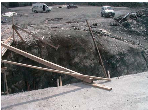
Φωτο 28: Σημείο χωρίς προστατευτικά κιγκλιδώματα δίπλα σε γέφυρα πρόσβασης των εργαζομένων
