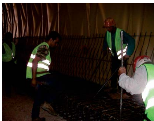
Φωτο 34: Εξάσκηση μεγάλης δύναμης κατά την τοποθέτηση διχάλας στον οπλισμό
