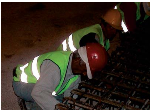
Φωτο 33: Επίπονες στάσεις εργασίας κατά την τοποθέτηση σιδηρού οπλισμού σε σήραγγα
