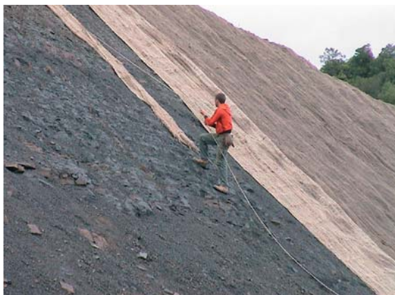
Φωτο 31: Εργαζόμενος σε εργασία τοποθέτησης γεωφάσματος σε βράχο χωρίς καμία προστασία για πτώση
