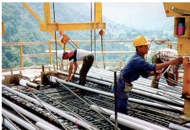
Φωτο 1: Εργασίες προέντασης σε γέφυρα
