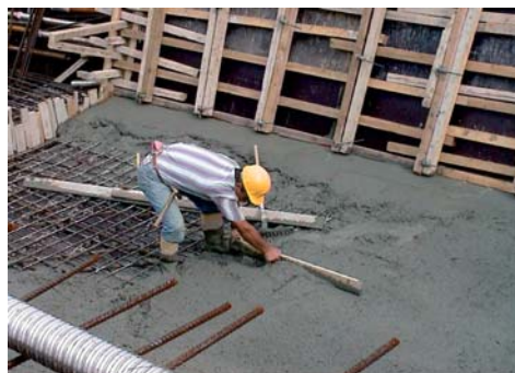
Φωτο 41: Επίπονη στάση εργασίας κατά τη διάστρωση
