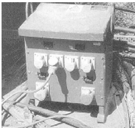
Φωτο 21: Μονάδα διανομής ηλεκτρικού ρεύματος
