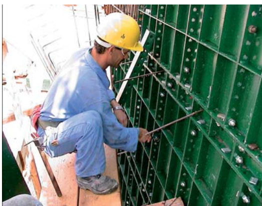
Φωτο 36: Βίδωμα μπουλονιών για τη σταθεροποίηση μεταλλότυπου
