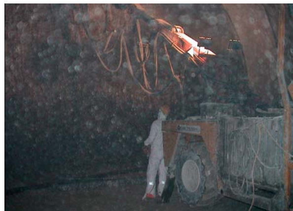
Φωτο 9: Χειριστής εκτοξευόμενου σκυροδέματος πολύ κοντά στην επικίνδυνη ζώνη
