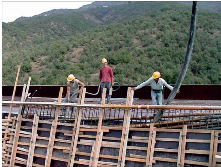
Φωτο 14: Προστατευτικό ανεπαρκούς ύψους σε γέφυρα
