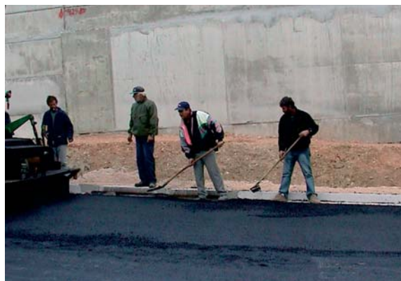
Φωτο 45: Εργαζόμενοι με τσουγκράνες που ακολουθούν το finisher στρώνοντας την άσφαλτο
