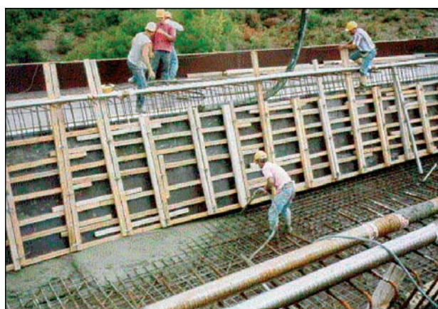
Φωτο 27: Γέφυρες με ανεπαρκή προστατευτικά κατά των πτώσεων
