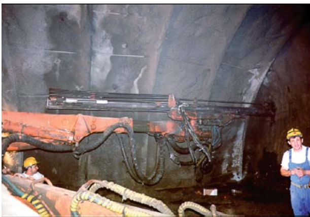
Φωτο 8: Εργαζόμενοι πολύ κοντά στο σημείο διάτρησης με κίνδυνο τραυματισμού από κινούμενα μέρη
