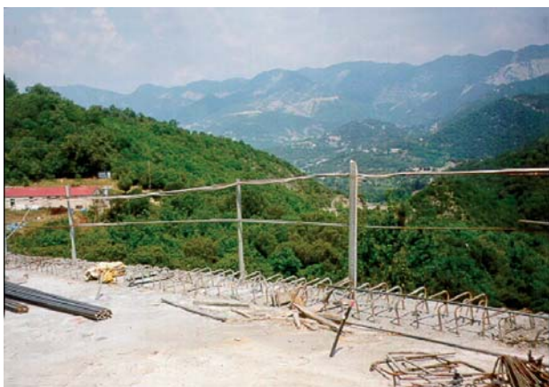
Φωτο 27: Γέφυρες με ανεπαρκή προστατευτικά κατά των πτώσεων
