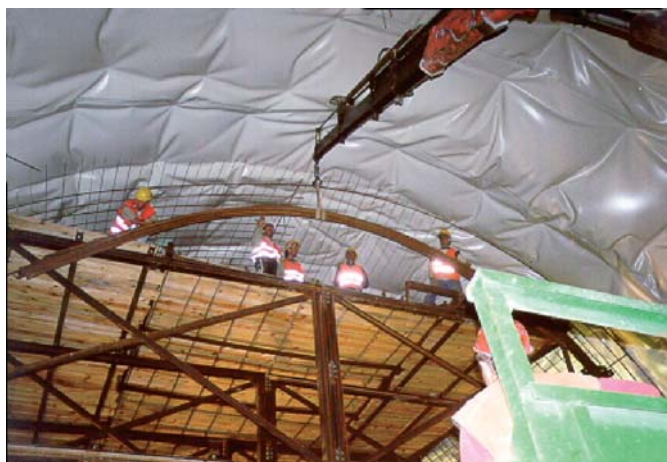
Φωτο 29: Πατάρια όπου έχει αφαιρεθεί το κιγκλιδώμα κατά τη μεταφορά οπλισμού
