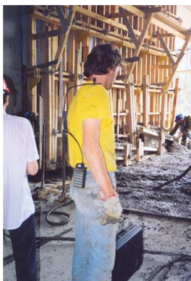
Φωτο 42: Μετρήσεις θορύβου με φορητό ηχώμετρο σε εργασία σκυροδέτησης γέφυρας
