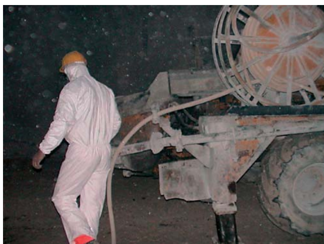
Φωτο 24: Χρήση μάσκας και προστατευτικού ρουχισμού σε εκτόξευση σκυροδέματος
