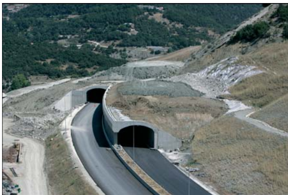
Φωτο 2: Σήραγγα με τη μέθοδο cut and cover
