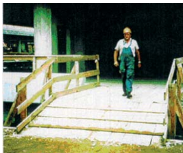
Φωτο 20: Εργαζόμενος σε διαμορφωμένη γέφυρα διάβασης
