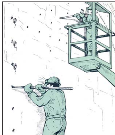
Φωτο 15: Εργαζόμενοι σε εξέδρες εργασίας για την τοποθέτηση εκρηκτικών σε σήραγγα
