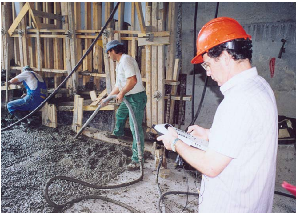
Φωτο 43: Μέτρηση δονήσεων στα άνω άκρα κατά τη χρήση δονητών σκυροδέματος
