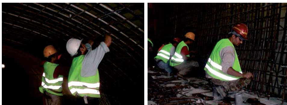
Φωτο 37: Τοποθέτηση οπλισμού σε πλαϊνά τοιχώματα σήραγγας
