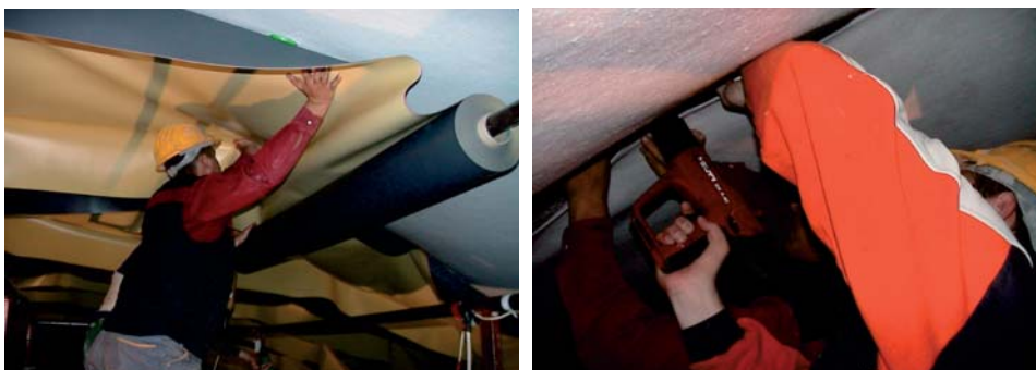
Φωτο 38: Τοποθέτηση μονωτικής μεμβράνης σε πλαϊνά σήραγγας
