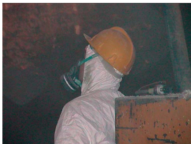
Φωτο 24: Χρήση μάσκας και προστατευτικού ρουχισμού σε εκτόξευση σκυροδέματος
