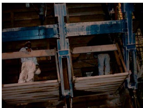
Φωτο 46: Εργαζόμενος σε εργασίες σκυροδέτησης πάνω σε φορέα καλουπιών σε σήραγγα
