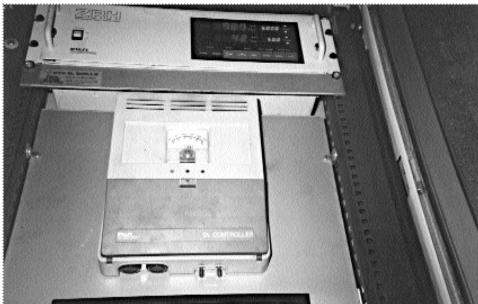
Μόνιμα εγκατεστημένες συσκευές ανίχνευσης αερίων
