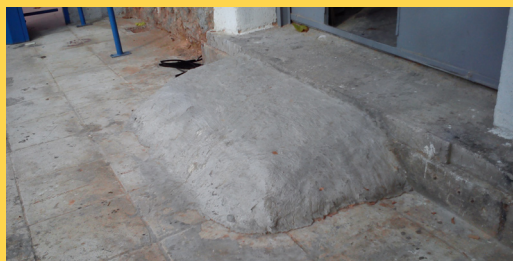
Ολισθηρό και απότομο σκαλοπάτι με κίνδυνο πτώσης σε σημείο όπου γίνεται μεταφορά βαριών φορτίων
