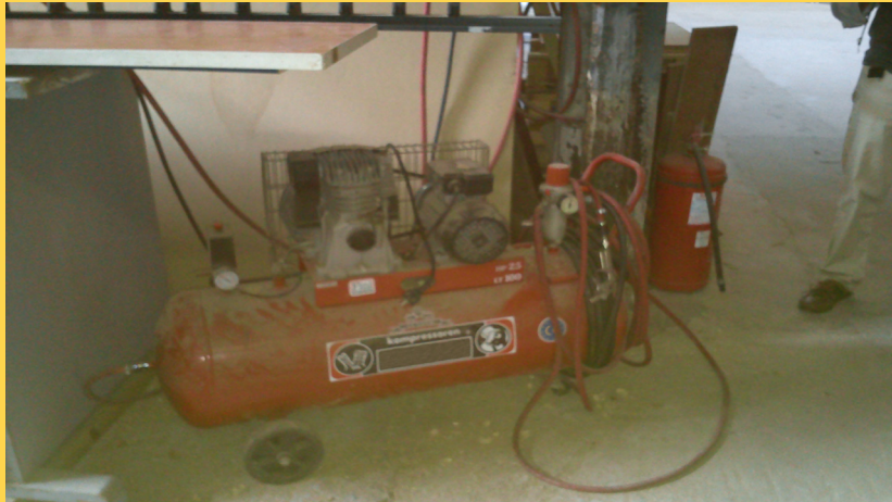
Αεροσυμπιεστής στον χώρο του ξυλουργείου
