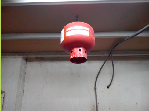
Πυροσβεστήρας οροφής
