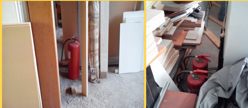
Πυροσβεστήρες χωρίς εύκολη πρόσβαση
