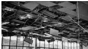
Καταστροφή ψευδοροφής.
