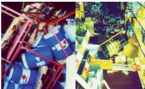
Ανατροπή υλικών σε αποθηκευτικούς χώρους, λόγω ανεπαρκούς αντισεισμικής προστασίας των ραφιών και ακατάλληλου τρόπου τοποθέτησης των υλικών-προϊόντων. (Καταστροφή υλικών, κίνδυνος ανάφλεξης ή αντίδρασης, αποκλεισμός διεξόδου διαφυγής)
