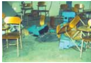
Ανατροπή συσκευών μεγάλης αξίας λόγω ανεπαρκούς στερέωσης.
