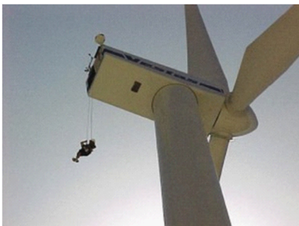
Εικόνα 5: Διαδικασία διάσωσης εξωτερικά του πύργου της ανεμογεννήτριας (Πηγή: windpowerengineering.com )
