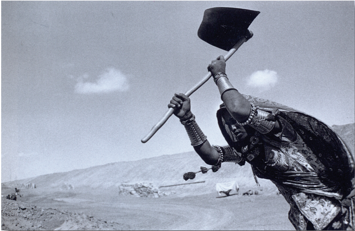
Στιγμιότυπα από την κατασκευή του καναλιού του Πατσαστάν, Ινδία, 1990 (φωτογραφίες του Sebastião Salgado)
