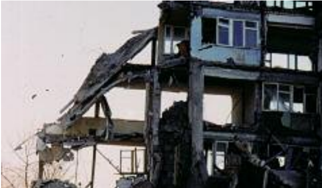
Καταστροφές στο φέροντα οργανισμό από σεισμό.
