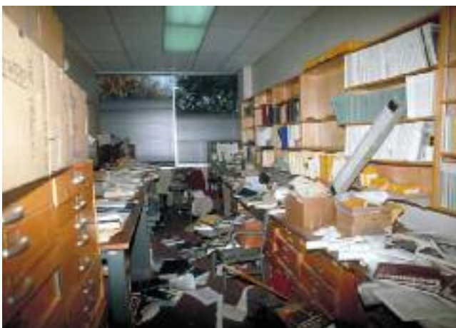
Ζημιές σε εξοπλισμό και επίπλωση εργασιακών χώρων
