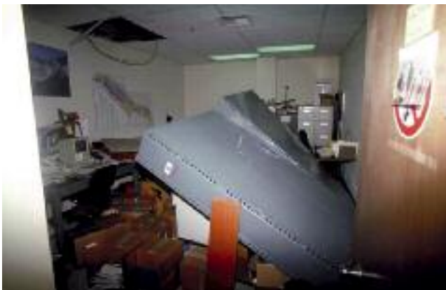
Ζημιές σε εξοπλισμό και επίπλωση εργασιακών χώρων
