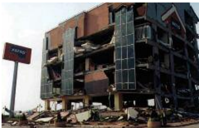
Καταστροφές σε μη δομικά στοιχεία της όψης του κτηρίου από σεισμό.
