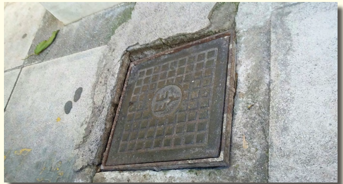
Εικ. 1: Σχάρα σε κακή κατάσταση
