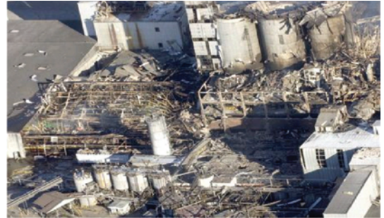
Σχήμα 1: Έκρηξη σκόνης σε εργοστάσιο κατεργασίας ζάχαρης, Georgia (ΗΠΑ) 2008 [7]
