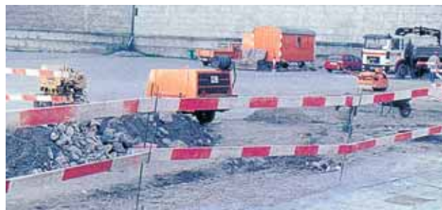
➤ Ασφαλής περίφραξη τμήματος εργοταξίου.
