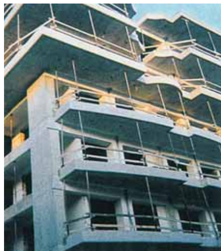
Ασφαλής προστασία στα πέρατα των εξωστών με πατοκολώνες και οικοδομικό πλέγμα/ σανίδια.
