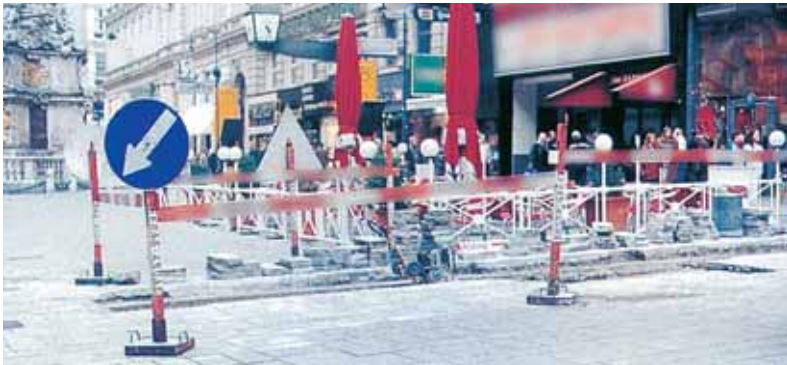
Ασφαλής περίφραξη και σήμανση εργοταξίου.
