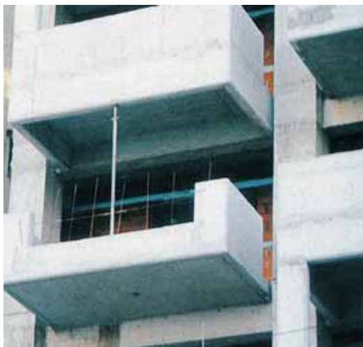
Ασφαλής προστασία στα πέρατα των εξωστών με πατοκολώνες και οικοδομικό πλέγμα/ σανίδια.
