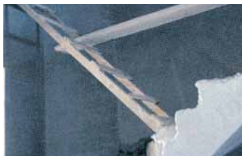
Λανθασμένη και ανασφαλής χρήση φορητών κλιμάκων για έδραση δαπέδων εργασίας.
