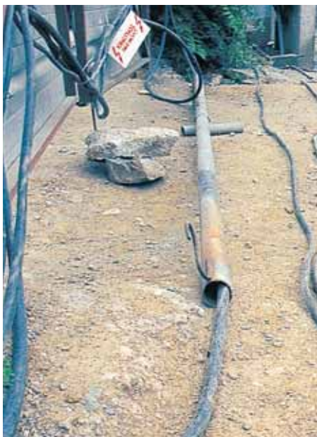
Προστασία καλωδίων από μηχανική φθορά.
