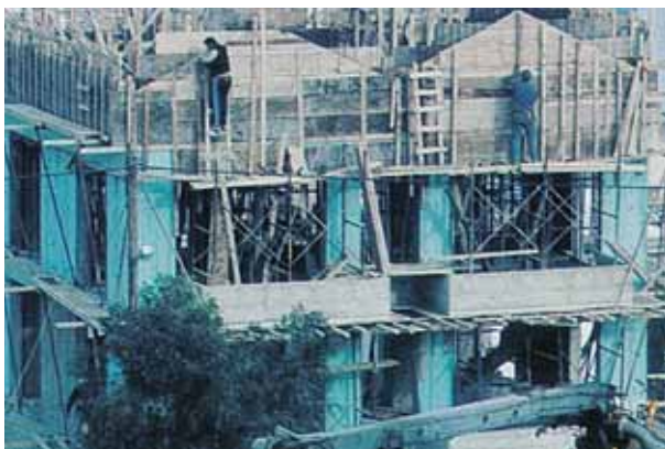
▲ Ανασφαλής χρήση φορητής σκάλας σε εξωτερικό δάπεδο εργασίας, απροστατέυτο έναντι πτώσης.
