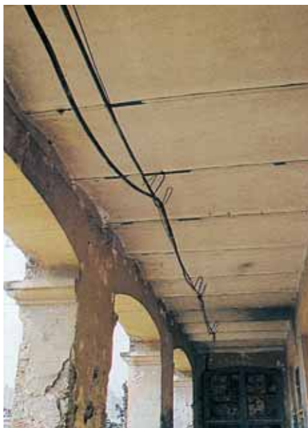
Ασφαλής ανάρτηση καλωδίων.
