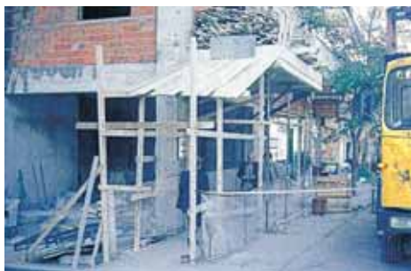
Προστατευτικό προστέγασμα με ακατάλληλη - επικίνδυνη κλίση.
