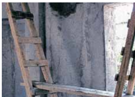
Λανθασμένη και ανασφαλής χρήση φορητών κλιμάκων για έδραση δαπέδων εργασίας.
