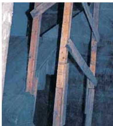
Καλή προστασία στο φανάρι (κου- βάς) κλιμακοστασίου.
