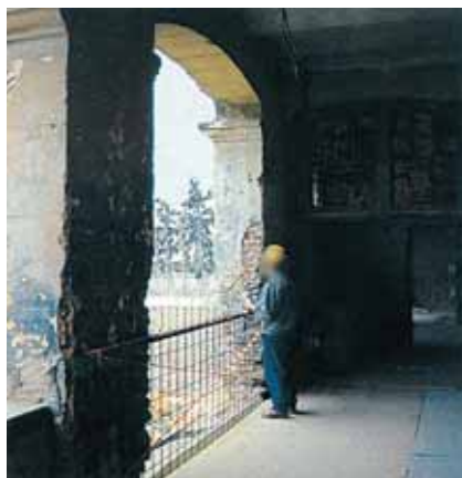
Ασφαλής προστασία και σήμανση στα πέρατα ξυλότυπου.
