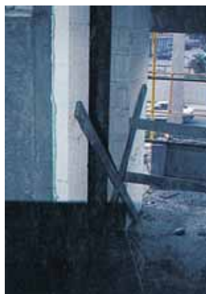
Απαράδεκτη προστασία ανοίγματος ανελκυστήρα.
