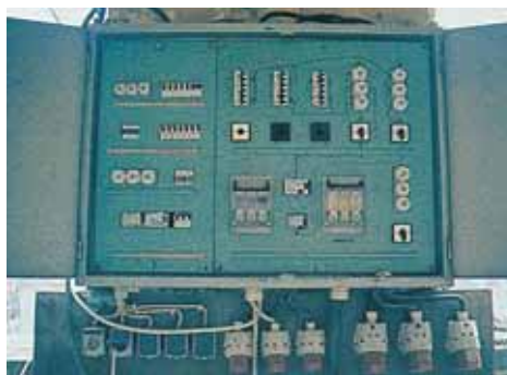
Δεν ξεχνάμε τον αντιηλεκτροπληξιακό διακόπτη (συνδεδεμένο με όλες τις παροχές) και την καθημερινή δοκιμή της καλής λειτουργίας του.
