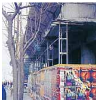
◀ Περίφραξη εργοταξίου με άδεια κατάληψης πεζοδρομίου. Προστατευτικό προστέγασμα. Απαιτείται συμπλήρωσή του στο γωνιακό τμήμα.
