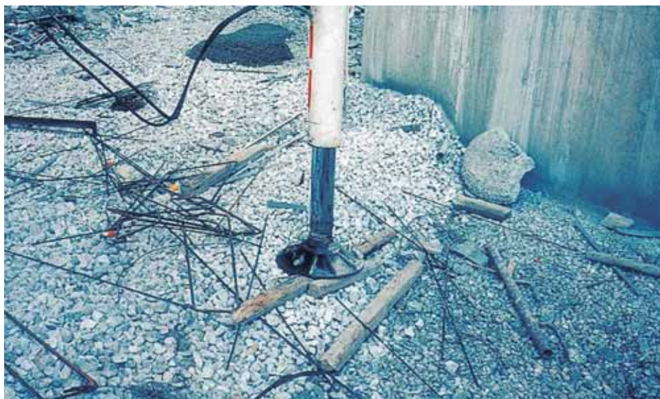
Απαράδεκτο προστατευτικό προστέγασμα (ακατάλληλη κλίση και υλικά, περιορισμένο μήκος).
