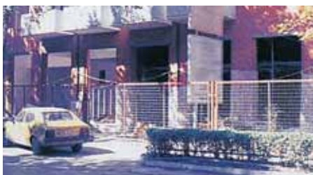
➤ Καλή περίφραξη εργοταξίου. Οργανωμένο εργοτάξιο.
