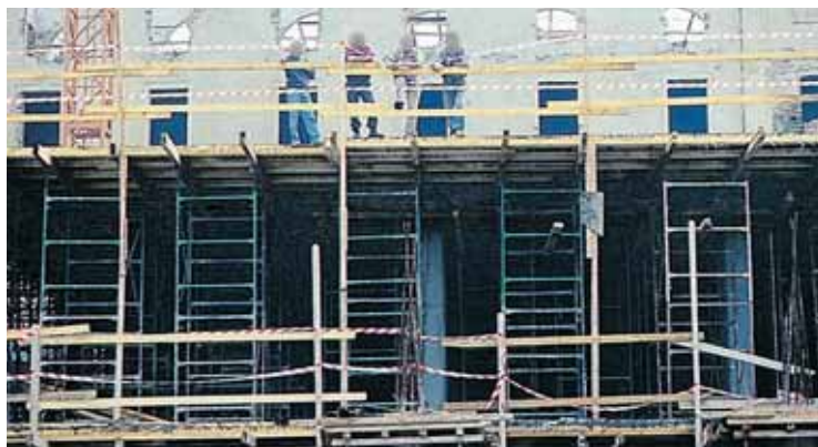
Ασφαλής προστασία και σήμανση στα πέρατα ξυλότυπου.
