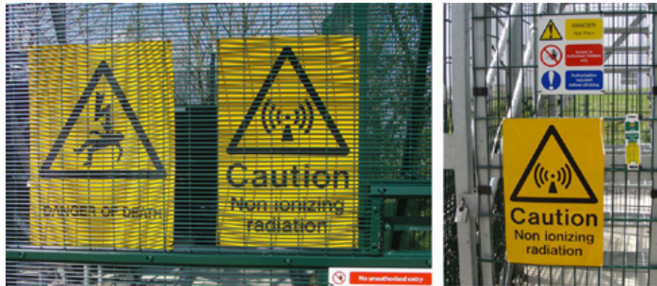
Σχήμα 12.4 — Ανάρτηση προειδοποιητικών σημάτων στην πύλη του συγκροτήματος του ραντάρ (αριστερά) και στην πύλη του πύργου της κεραίας (δεξιά)
