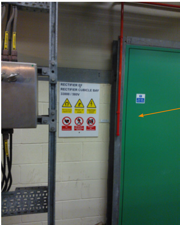
Σχήμα 3.3 — Περιορισμός της πρόσβασης σε συστοιχία κλωβών ανορθωτή
