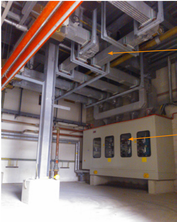
Σχήμα 3.3 — Περιορισμός της πρόσβασης σε συστοιχία κλωβών ανορθωτή
