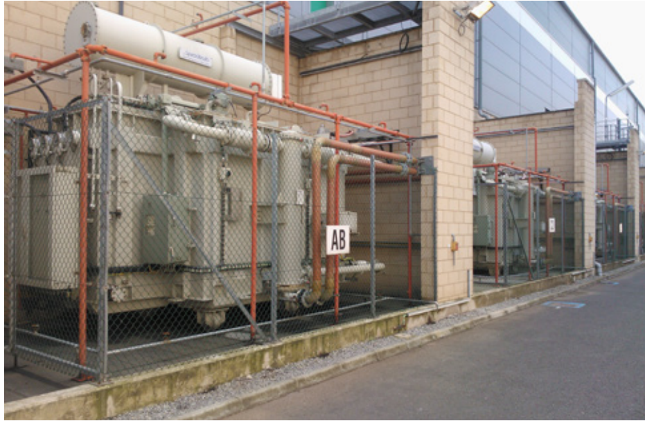
Σχήμα 3.4 — Οι συστοιχίες μετασχηματιστών
