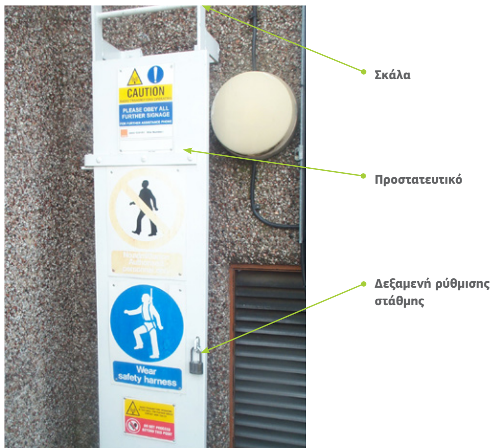
Σχήμα 9.2 — Χρήση προστατευτικής σκάλας για περιορισμό της πρόσβασης σε ισχυρά πεδία σε στέγες
